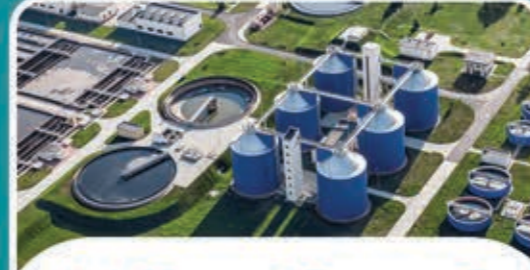
تصميم وتركيب وتشغيل محطات الصرف الصحي
